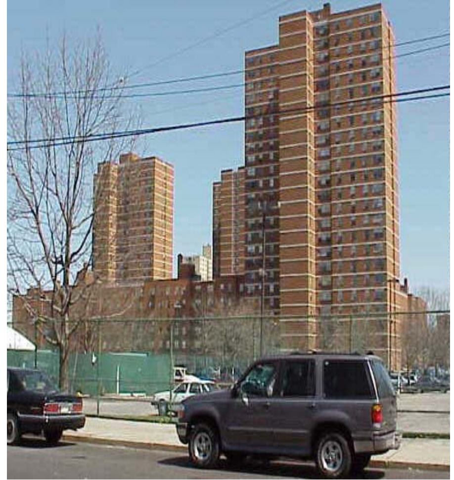
Stevenson Commons 1-70 KW Microturbine
